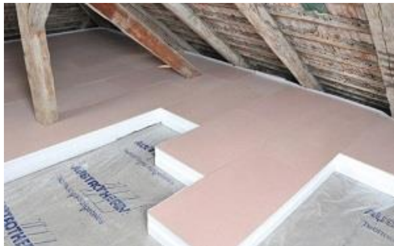
(2) Terhelhető EPS hőszigetelés faforgácslap járóréteggel
