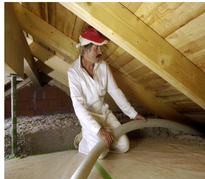
(3) Szórt cellulóz hőszigetelés
