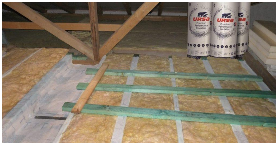
(1) Üveggyapot hőszigetelés pallók között
